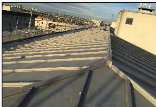
Rue Falkirk Créteil (94)
